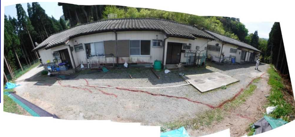
斜面亀裂状況
